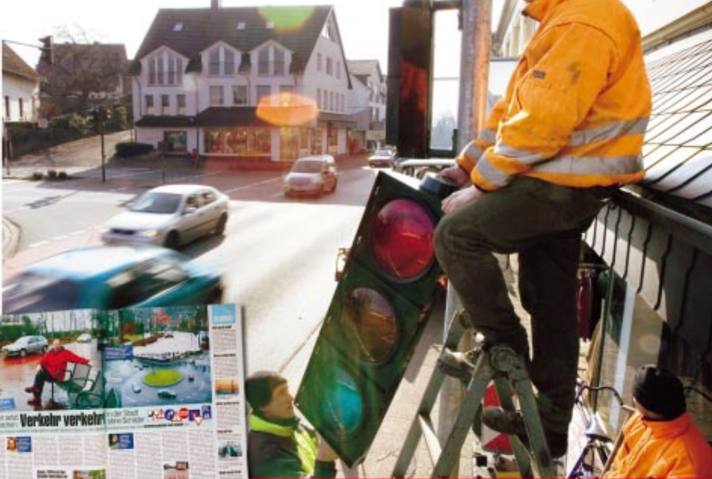
Vorgeschmack: Nach einem Unfall tauschen Techniker eine Ampel in Bohmte aus
