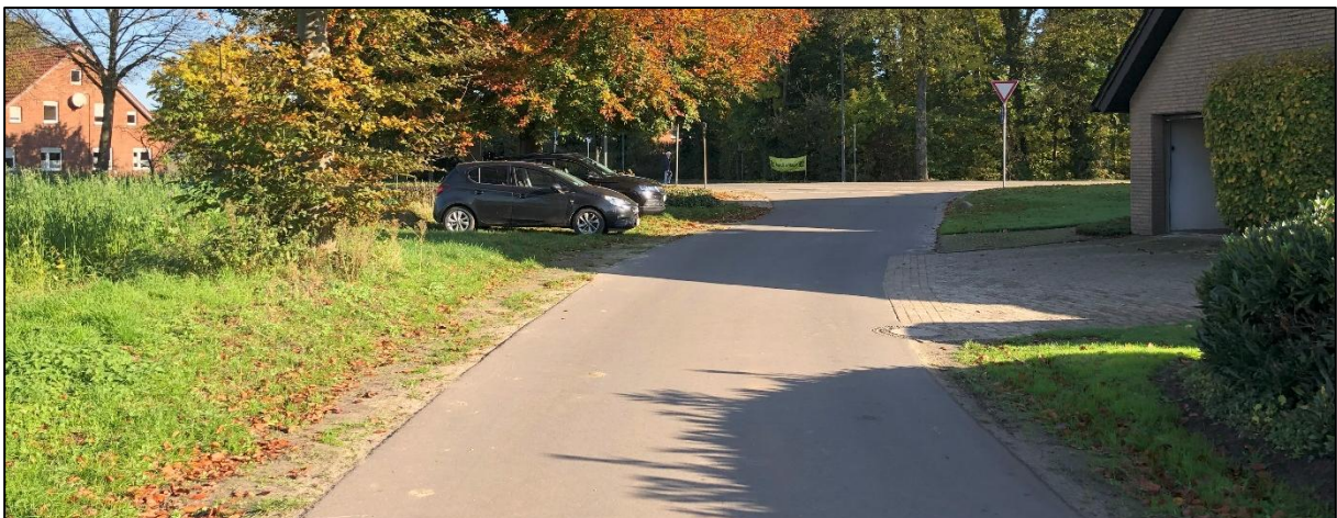
Abbildung 9: Vinkenburger Weg – Blickrichtung Nordost (Quelle: Aufnahme IPW)
