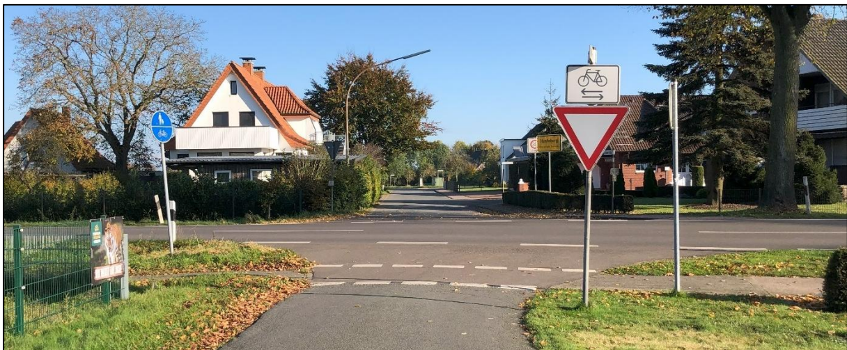
Abbildung 4: KP Dammer Str. / Im Pohl / Grüner Weg – Blickrichtung Nordost (Quelle: Aufnahme IPW)
