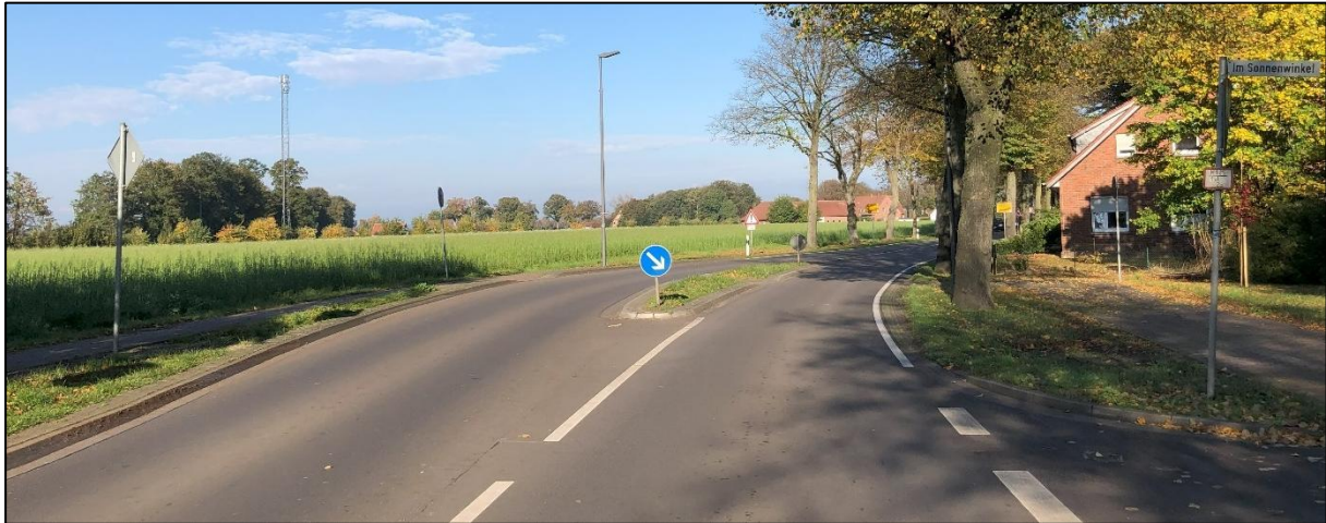
Abbildung 3: Querungshilfe Dammer Str. – Blickrichtung Nord (Quelle: Aufnahme IPW)
