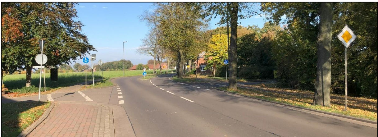
Abbildung 8: KP Dammer Str. / Vinkenburger Weg / Im Sonnenwinkel – Blickrichtung Nord (Quelle: Aufnahme IPW)
