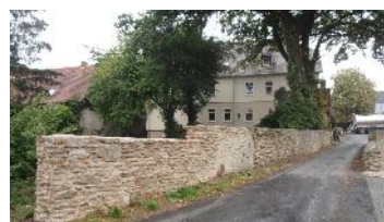
Vorhandene Bruchsteinmauer an der Straße 'Bahnwinkel'
