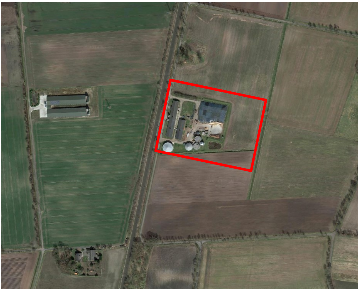
Abbildung 1: Standort der Biogasanlage Bohmte Nord [Quelle: Google Maps 2024, ohne Maßstab]
