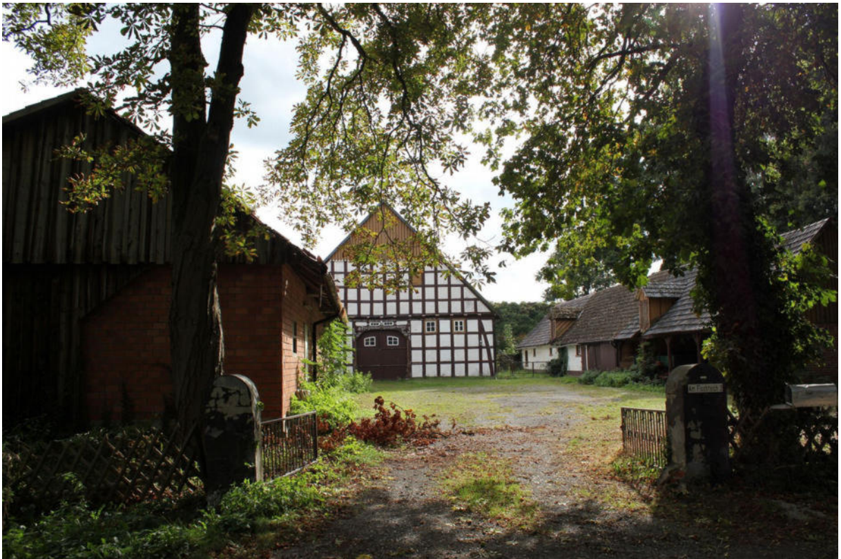
Hofstelle - Am Fischteich (Blickrichtung süd)
